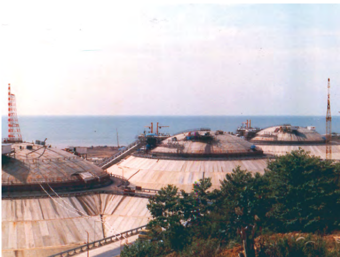
Earth Embankment LNG Storage Tanks ( TOYO KANETSU K.K. ) Sarawak, Malaysia
