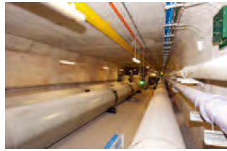
Marina Bay 共同溝の断面図・洞道内写真 出典) シンガポール再開発庁 HP より
