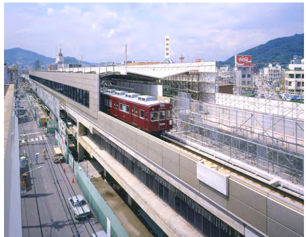
阪急電鉄 宝塚線 池田駅 大阪府 池田市 竣工:1986年
