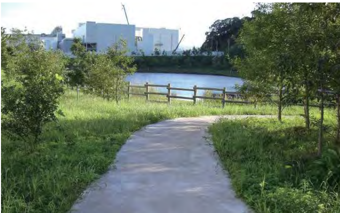
↑沈砂地を北東側から望む 園路舗装はリサイクルコンクリート舗装沈砂地外周の柵は生木の丸太組
