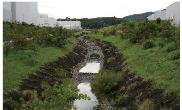
↑付替水路を東側（下流側）から望む 付替水路は多自然型護岸を採用
