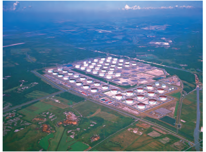
苫小牧東部国家石油備蓄基地
