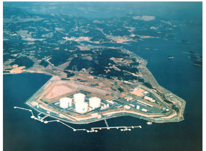
九州液化ガス福島基地 福島 LPG 基地
