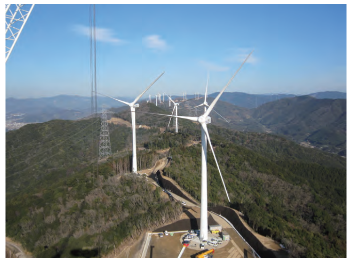
ガスアンドパワー 由良風力発電所
