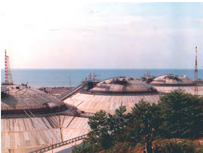
トーヨーカネツ サワラク LNG 地下タンク
