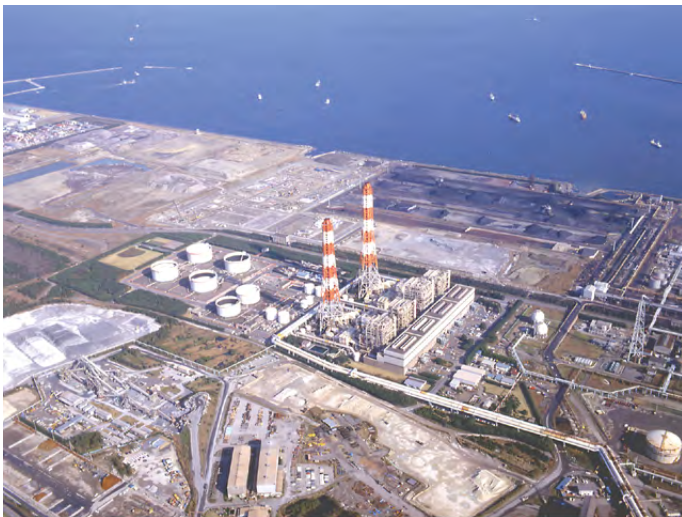
鹿島共同火力発電所 鹿島共同火力株式会社
