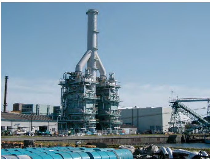
市原パワー市原発電所 市原パワー株式会社
