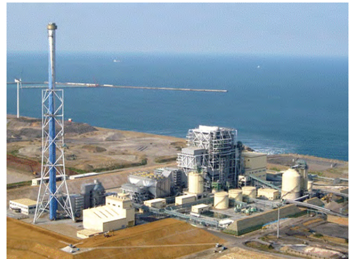
鹿島火力発電所 新日鐵住金株式会社
